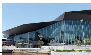
メルボルン国際会議場
